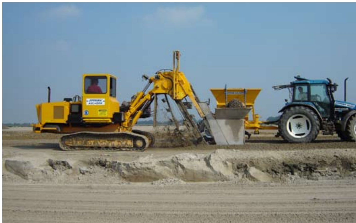
Met groot materieel is het zandpakket op de kleilaag aangebracht
