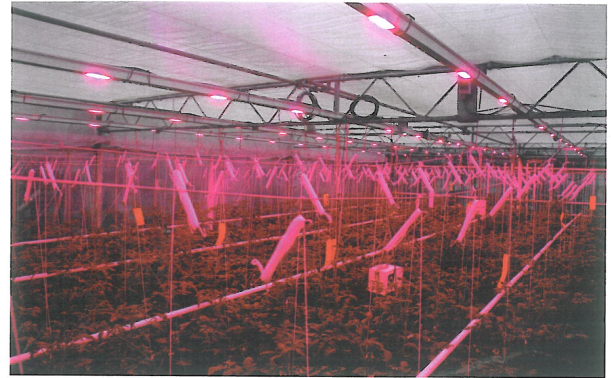
Hoe hoger het warmteoverschot, hoe eerder leds een gunstige extra lichtbron vormen. Een groeibuis is een optie voor hergebruik van led-warmte.
